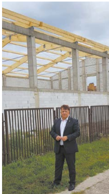
Budowa sali gimnastycznej przy ślubickim ogólniaku również nie jest zagrożona
